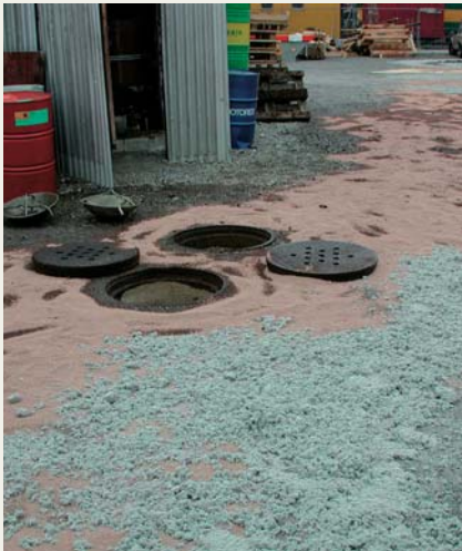
Unbefestigter, stark mit Heizöl verschmutzter Platz.
